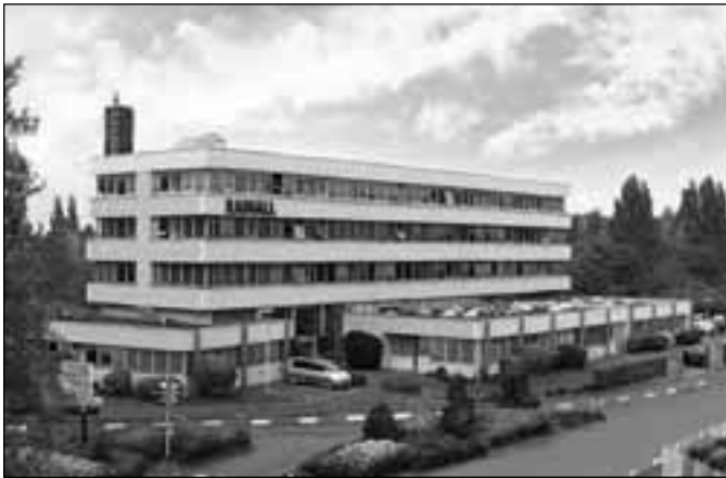
Head Office - Rosny sous Bois
